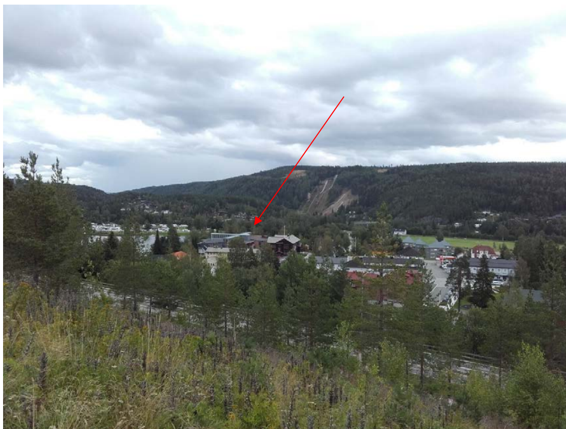
Foto: Deler av Rena sentrum og planområdet sett fra vest over RV. 3. Prestsjøen sees til venstre i bildet. Pil angir eksisterende Høgskolebygg.
