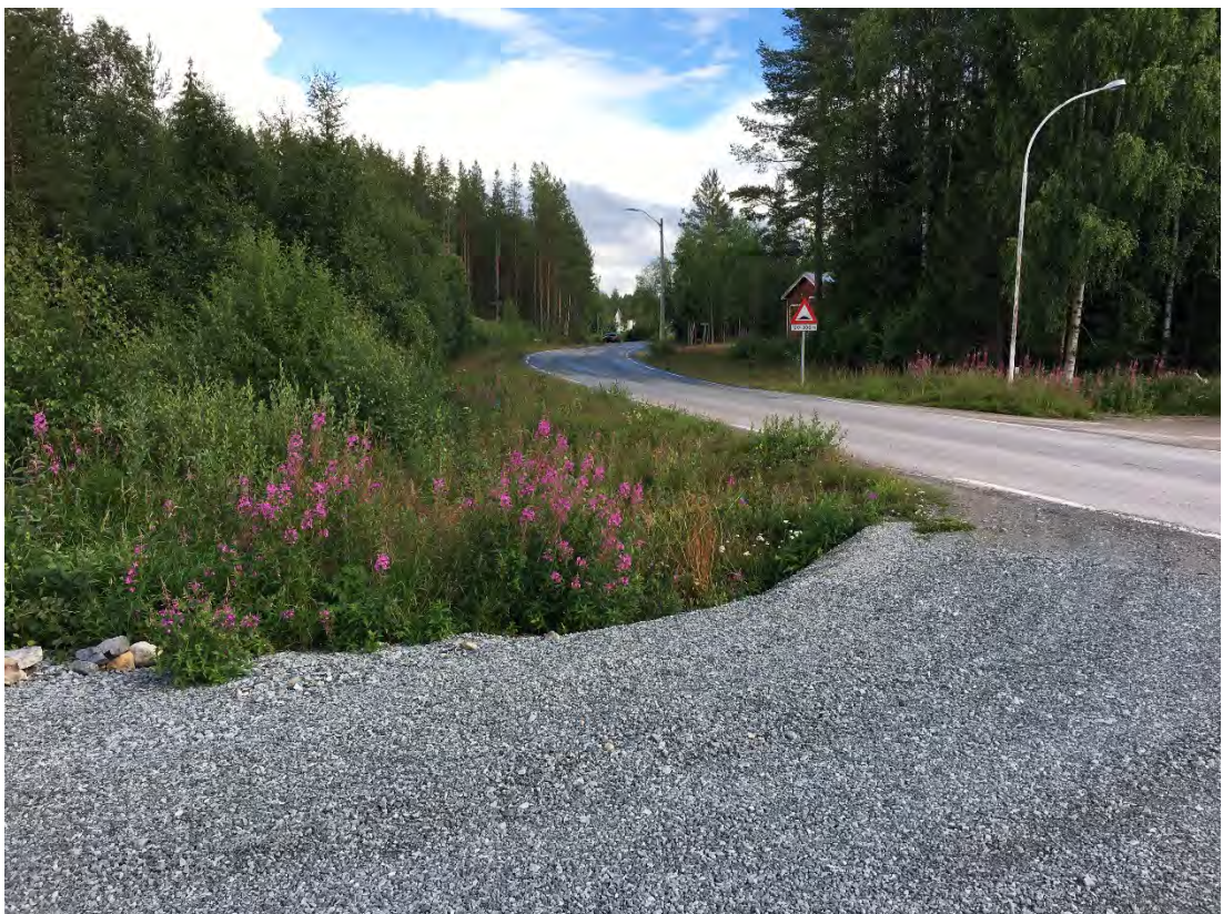
Figur 6.6.3: Bilde er tatt fra avkjøringen skogsbilvegen/Fv215 med 6 meter stoppsikt, mot øst og Fv215. Siktkravet på 6 x 45 meter er overholdt.
