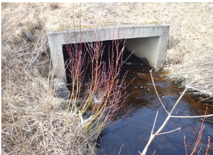
Figur 9: Kulvert under adkomst til flyhangarer
