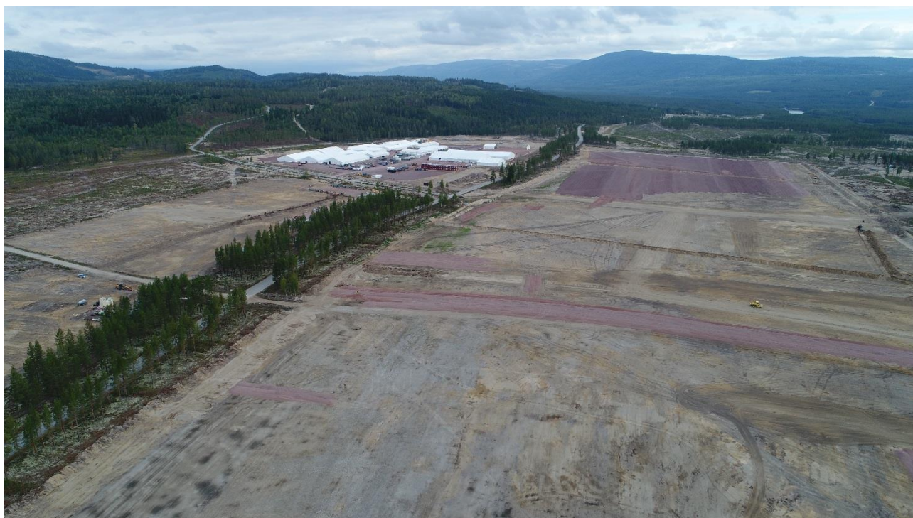
Figur 4. Bilde av hovedanlegget underveis i etableringen.
