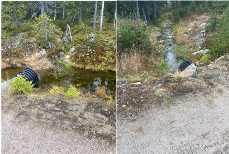
Figur 21. Bilde av innløp og utløp til 600 mm stikkrenne
