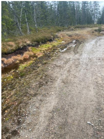
Figur 22. Bilde av terreng ved innløp til stikkrenne
