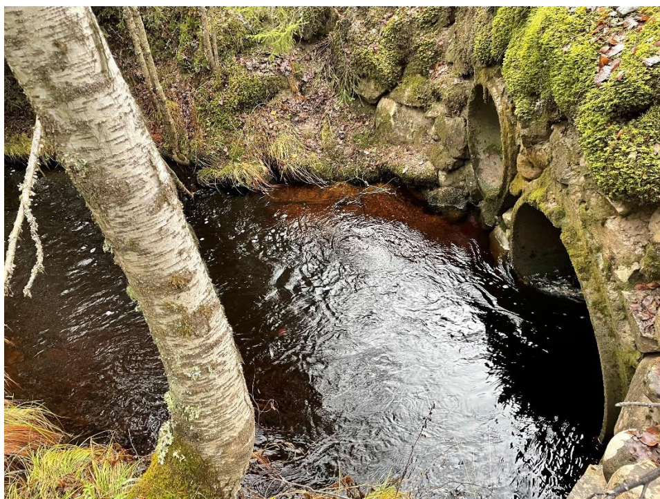
Figur 15: Stikkrenne under Bjørkevegen, før utløpet av Granåsbekken i Nordre Osa.
