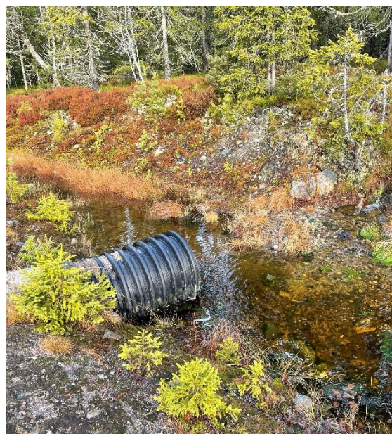
Figur 14: Stikkrenne nedstrøms Tjennstuåsen som bør utbedres.
