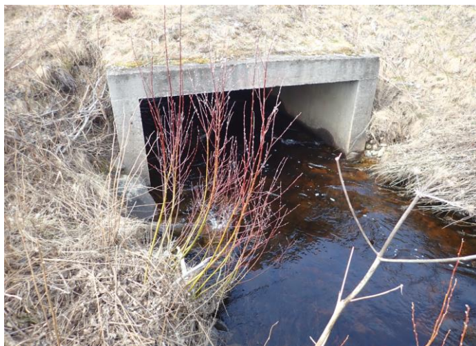
Figur 9: Kulvert under adkomst til flyhangarer
