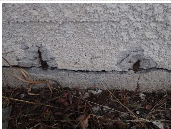
231-01 Riss og oppsprekking i mur rundt svømmehall. Mot vest.
