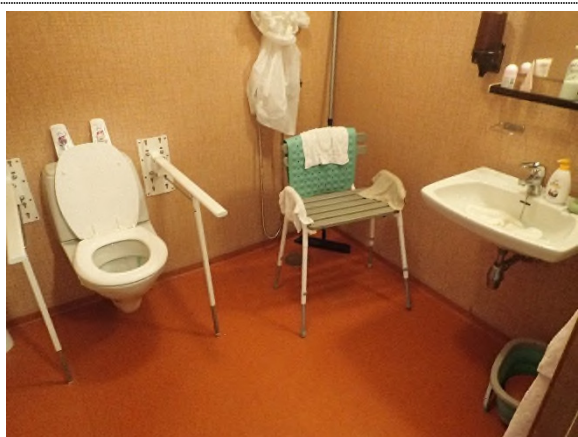
246-01 Generelle overflater i opprinnelige bad.
