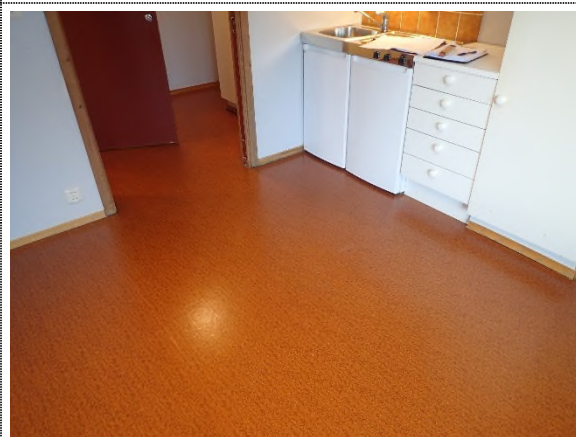
255-01 Typisk standard på gulvbelegg i beboerrom. Fra byggeår.
