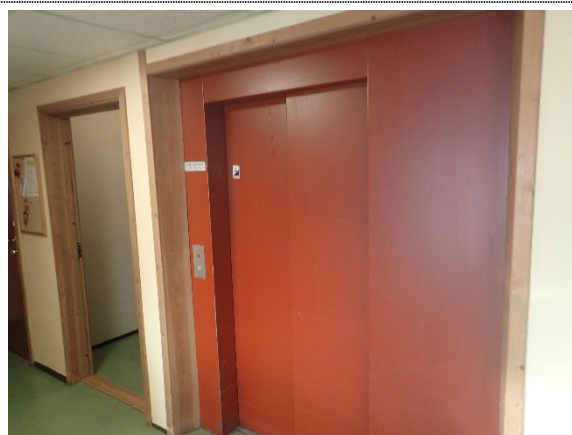
620-01 Heis er fra byggeår.
