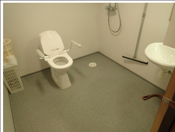
315-03 Sanitærutstyr i nyeste byggetrinn i god stand.
