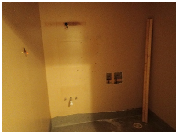
315-03 Flere eldre bad er renovert/ under renoivering.
