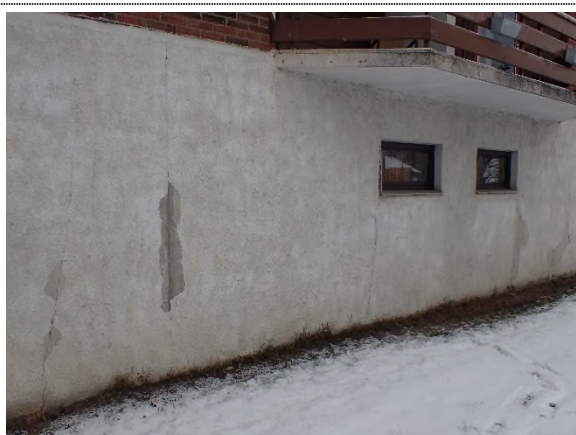
231-01 Riss og oppsprekking i mur rundt svømmehall. Mot vest.
