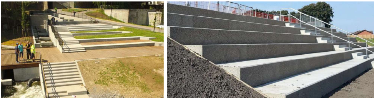
Figur 5-13. Eksempel på terrassering langs Møllefossen fisketrapp (venstre) og tribuner i betong som er bygget inn til en skråning (høyre) (Poundfield Precast, 2025)
