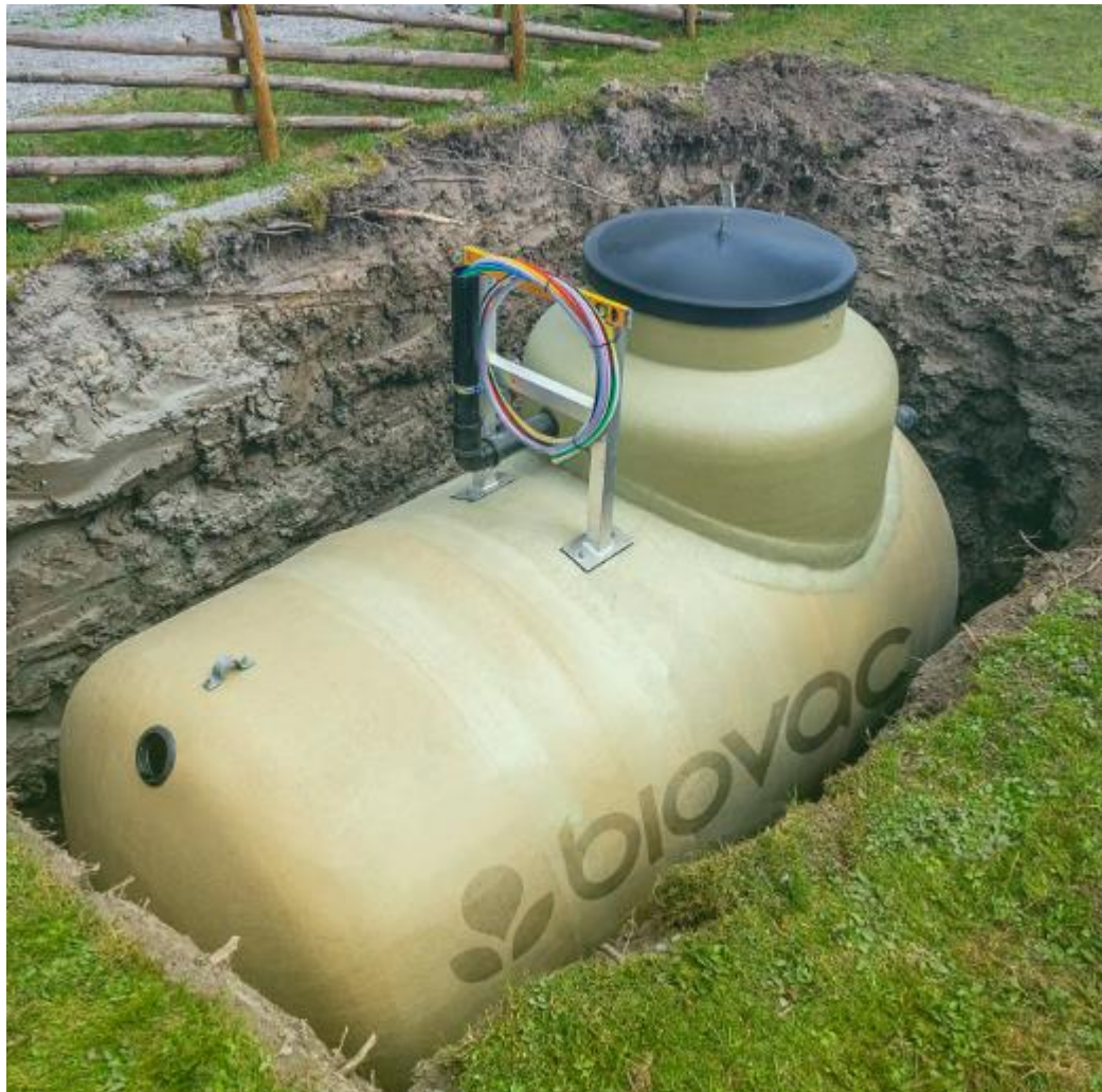
Minirenseanlegg- Eksempel hentet fra Biovac produkter
