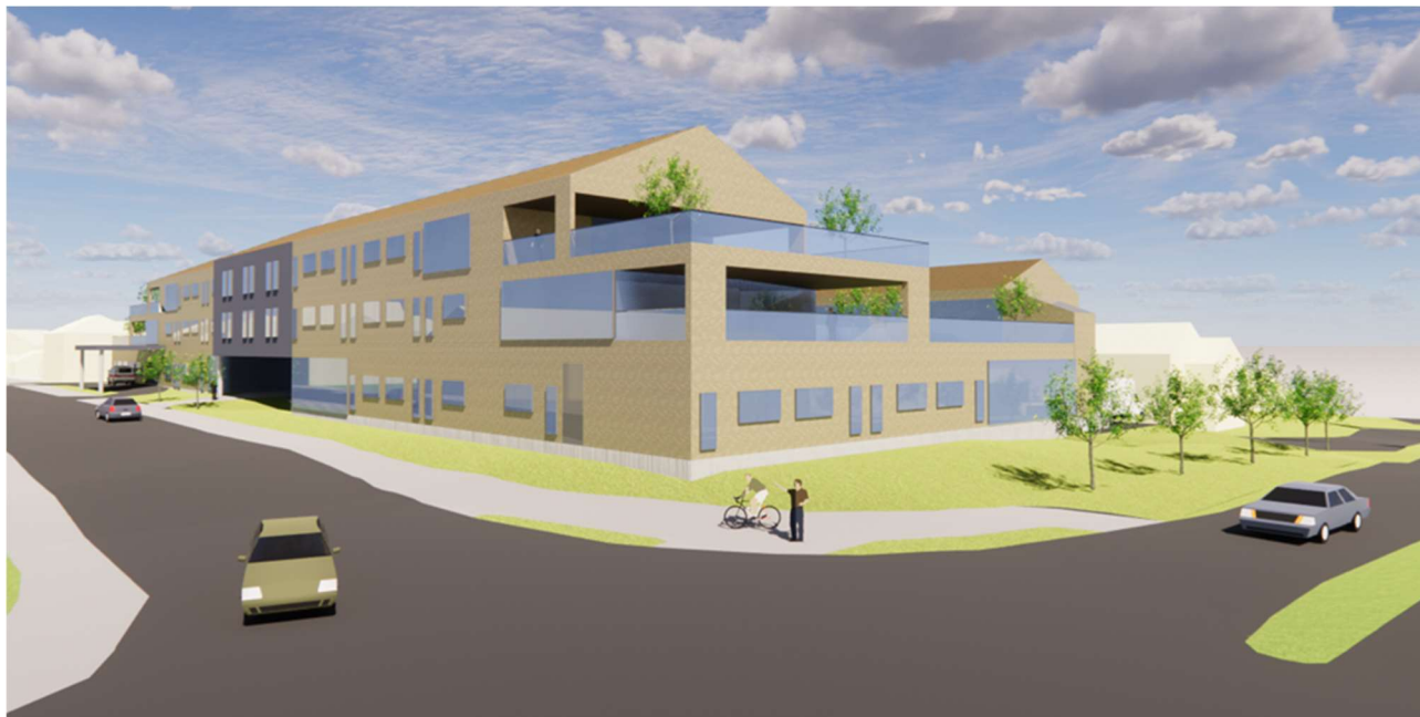
Figur 23: Alternativ 3: Sett fra krysset Haugedalsveien og Tollef Kildes gate.
