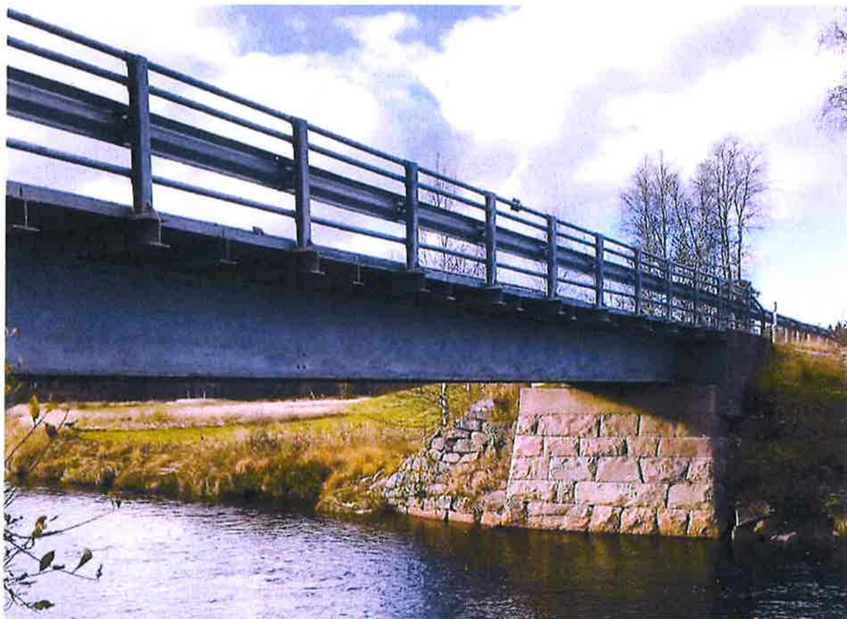
Figur 9 Jota bru sett fra nedstrøms side.
