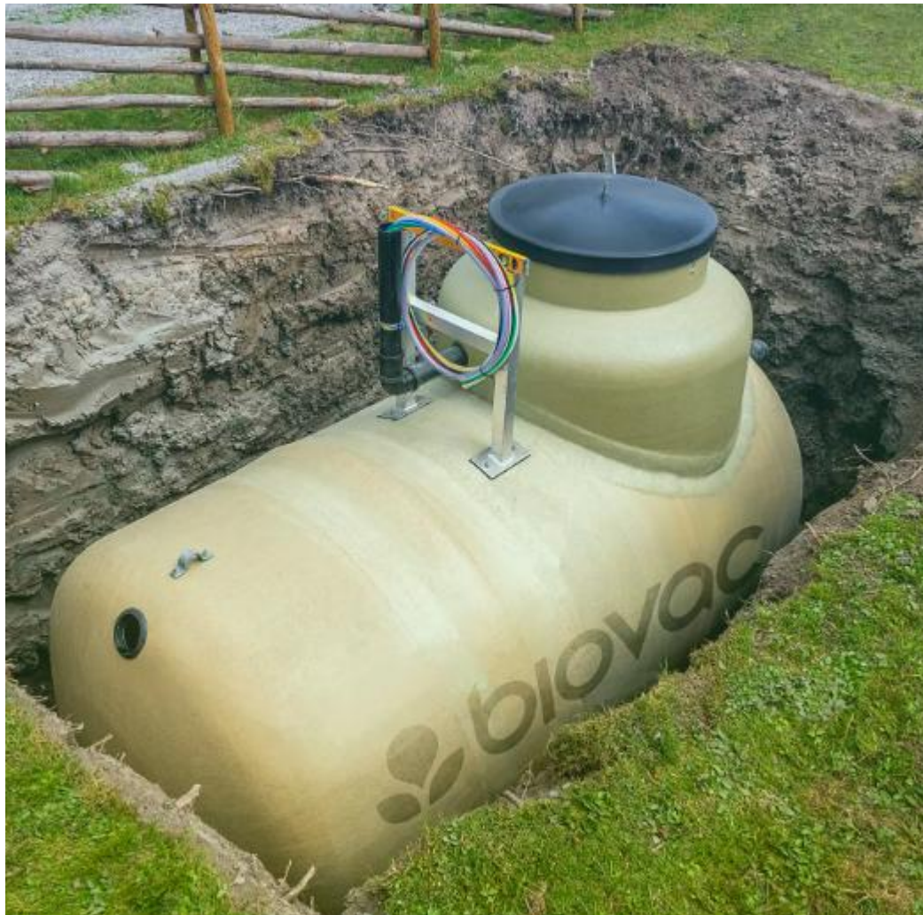
Minirensanlegg- Eksempel hentet fra Biovac produkter
