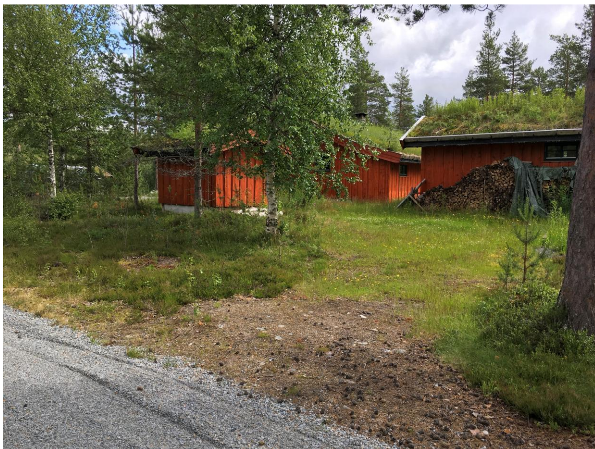
Bilde av pumpehus og felles drikkevannskilde på eiendommen 35/253
